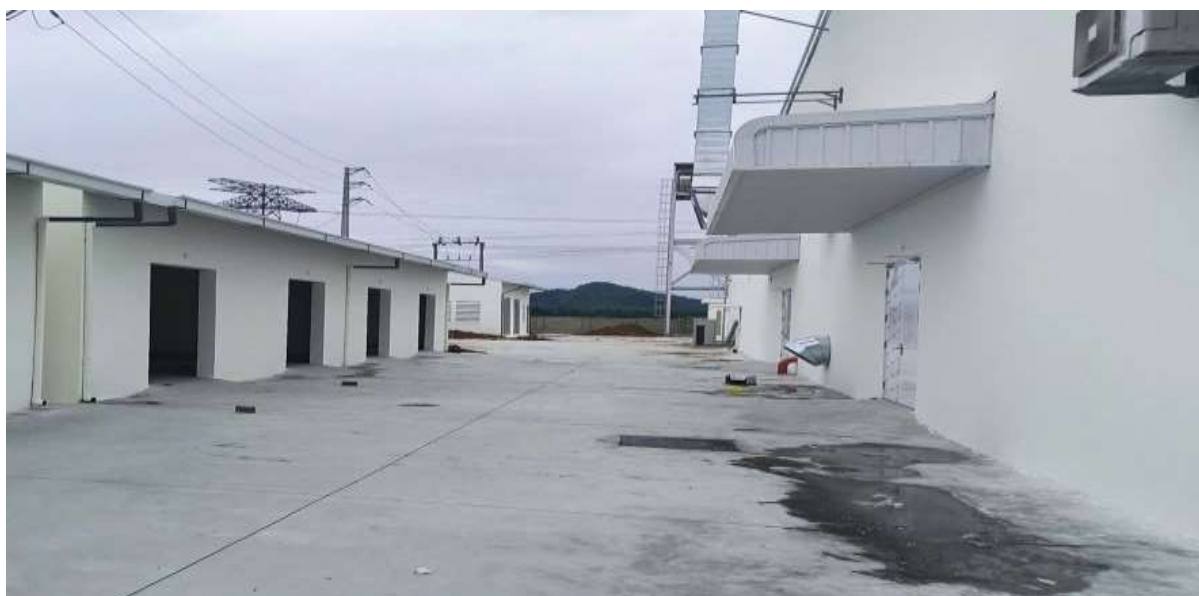
Hình 3.10. Kho chất thải rắn công nghiệp thông thường
